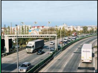
Chile - Norte Sur Project
